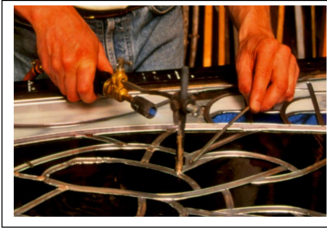
De verbindingen van het loodprofiel voor en achter solderen met tinsoldeer.
