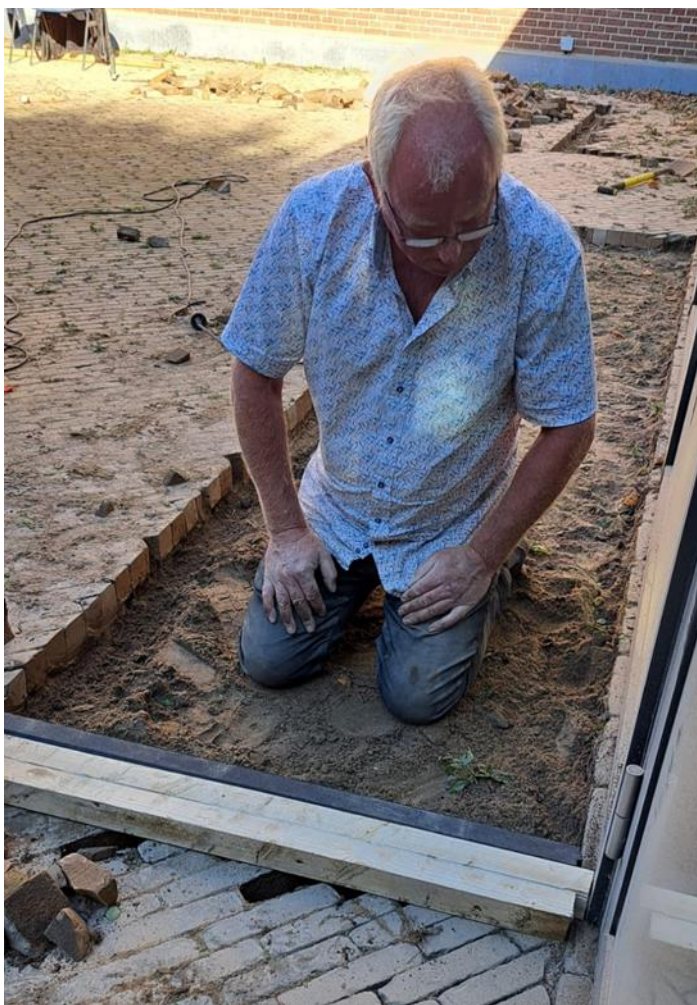
Een echte vakman maakt zijn eigen hulpmiddel: zo zorgt John ervoor dat de opsluitbanden op de goede hoogte komen.
