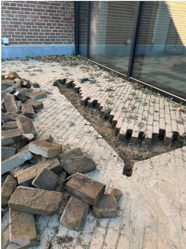
De contouren worden zichtbaar en het “Tegelwippen” is gestart.
