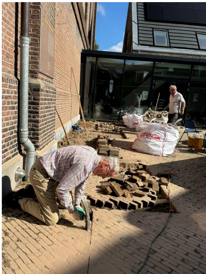
Nadat de stenen gezaagd zijn moeten ze nog wel worden uitgehakt.
